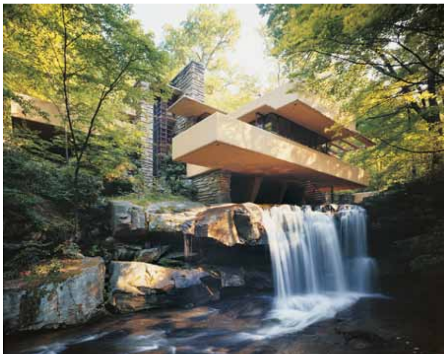
16-B 法蘭克·萊特 (1867-1959)·落水山莊 (考夫曼屋)·米爾溪·賓州·1935-1939 年。西賓州管理委員會提供的落水山莊照片。2006 年法蘭克·萊特基金會·史考特谷·亞利桑那州 / 藝術家權利協會 (ARS)·紐約。
